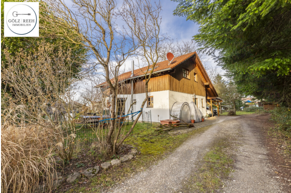
Blick von der Zufahrt
