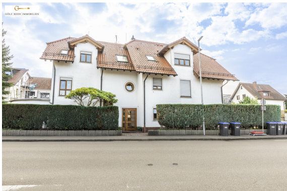
Blick von der Straße
