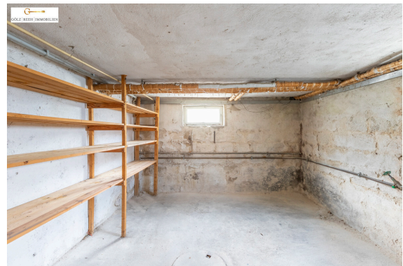
Kellerraum Nr. 1 von 5
